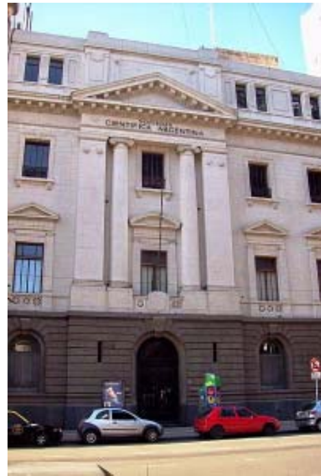
Figura 2. Fachada del edificio de la Sociedad Científica Argentina de la que Estanislao Severo Zeballos fue miembro fundador. Foto: Roberto Fiadone (Reservados todos los derechos de autor).
